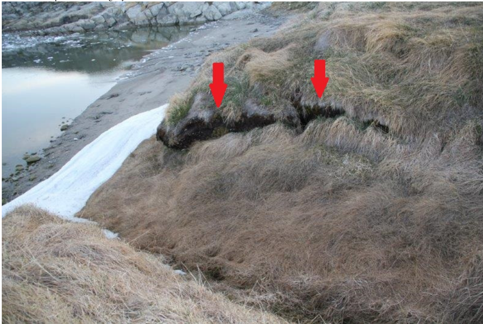
Fig. 4-12. Erosion af den nordlige væg af Meldgaards tværgrøft er tydelig (røde pile). Længden af tværgrøften kunne måske bruges til at give en ide om af hvor meget af bopladsens kant der er eroderet bort siden 1955. Ifølge Mathiassen forlængede han Meldgaards tværgrøft fra 7 m til 19 m i 1955. Som det ses af billedet og fig. 4-13, er det vanskeligt at bestemme hvor grøften begynder og ender, men dens længde ligger inden for 14-16 m, hvilket indikerer at 3-5 m af bopladsens kant er eroderet væk siden 1955.
