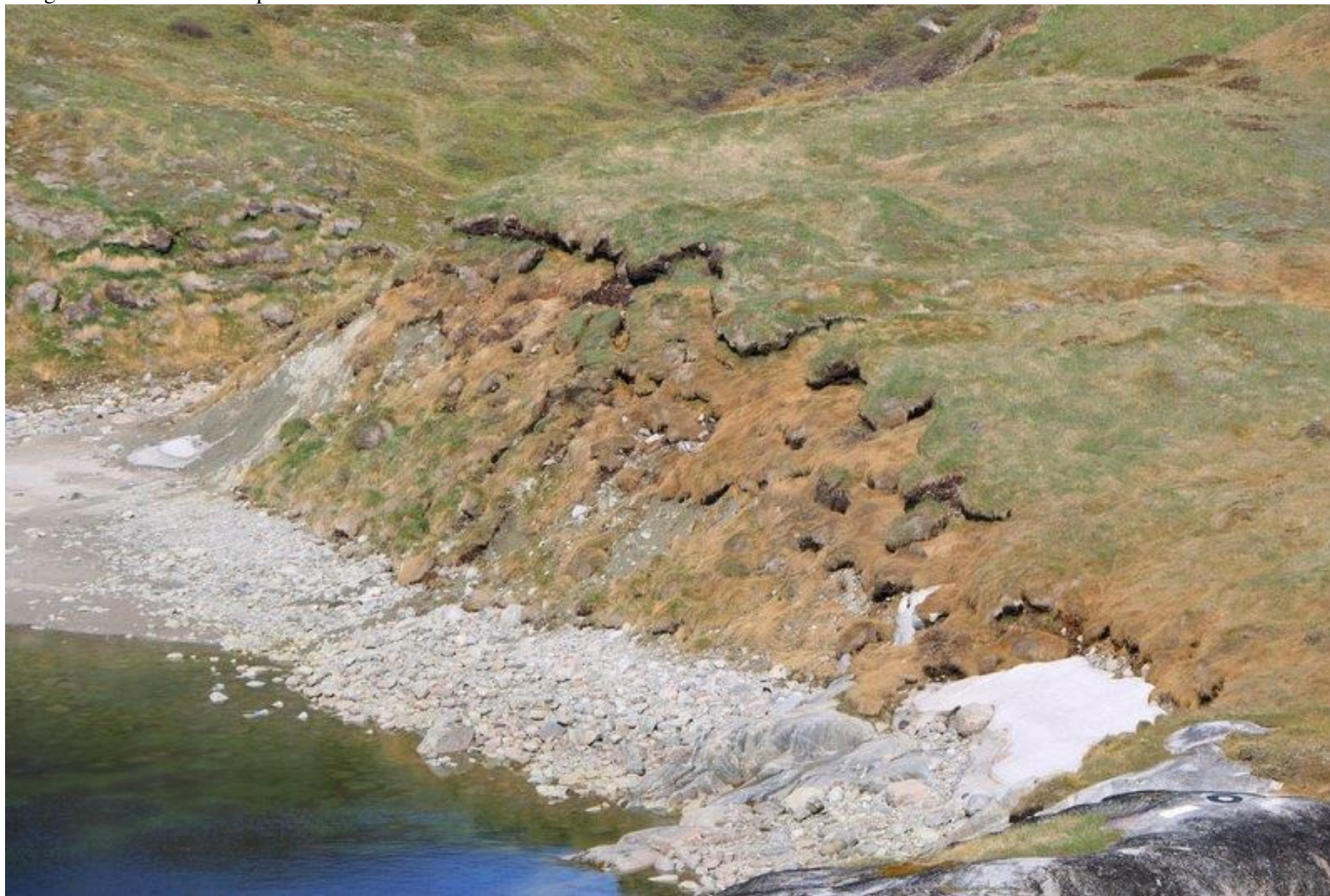
Fig. 1-11. Kystskrænt B. Erosionen er tydelig. Billedet er taget 10 dage efter besigtigelsen.
