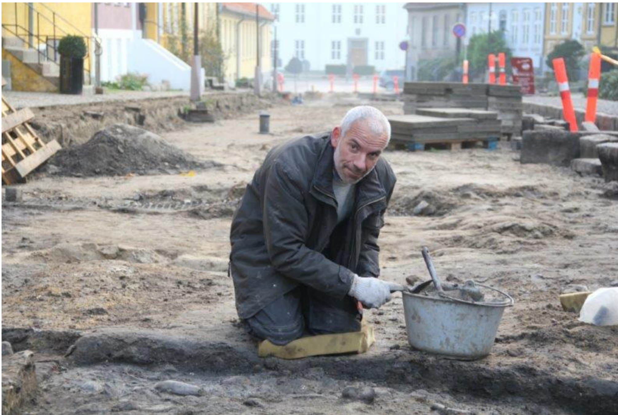
Martin Pavón i gang med at udgrave pigstensbelægningen.
