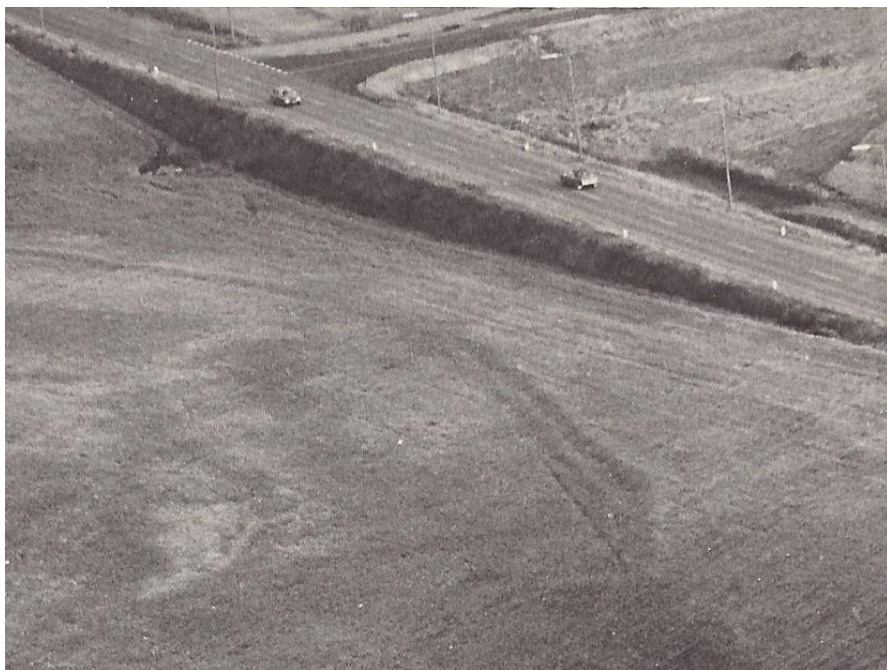
Det dobbelte grøftesystem ses tydeligt på dette luftfoto med den nyligt anlagte Industrivejs udmunding i Hovedgaden i baggrunden. Foto: Alfred (Alf) Petersen, d. 3. juli 1975.
