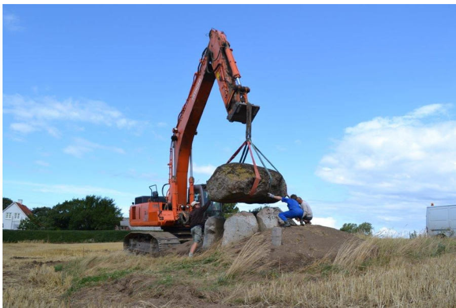
Låget lægges på plads.
