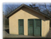
Forskolen og vaskehus med Wc'er.
