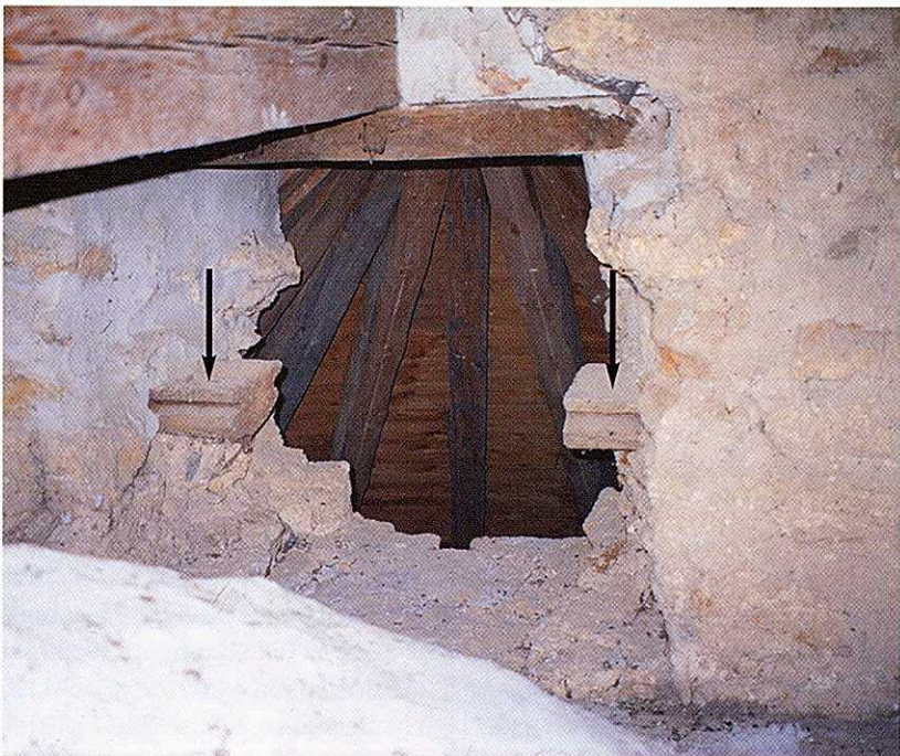
Fig. 18. Genbrugstømmer fra vikingetiden i Sæby Kirke. Kalkmalerier inde i kirkens apsis og korbue er dateret til første halvdel af 1100-årene og paralleller kendes fra andre kirker, der sættes i forbindelse med Hviderne. Dateringer uha. træets årringe har påvist, at træet som den indmurede planke er udhugget af, er fældet omkring 1040 e.Kr. Planken har oprindeligt stået i et andet bygningsværk, formentlig, 50–70 år, inden den omkring år 1100 blev genbrugt som ankerbjælke i murværket ved opførelsen af den lille romanske stenkirke. Foto Lisbeth Pedersen.
